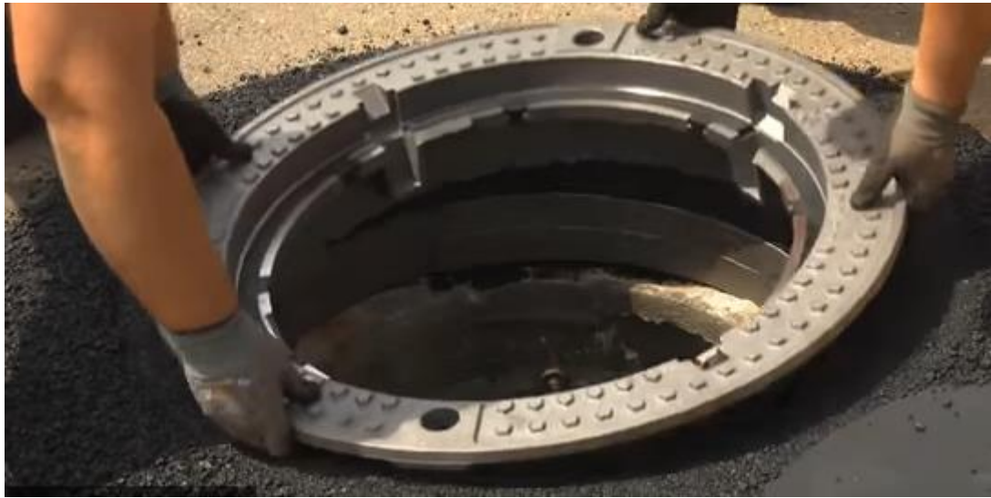
11. Производится установка люка и зачистка области люка
