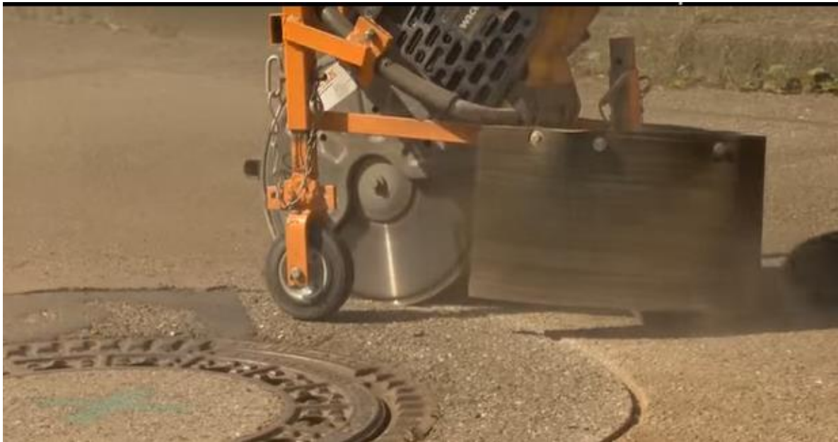
4. Демонтаж асфальта вокруг люка
