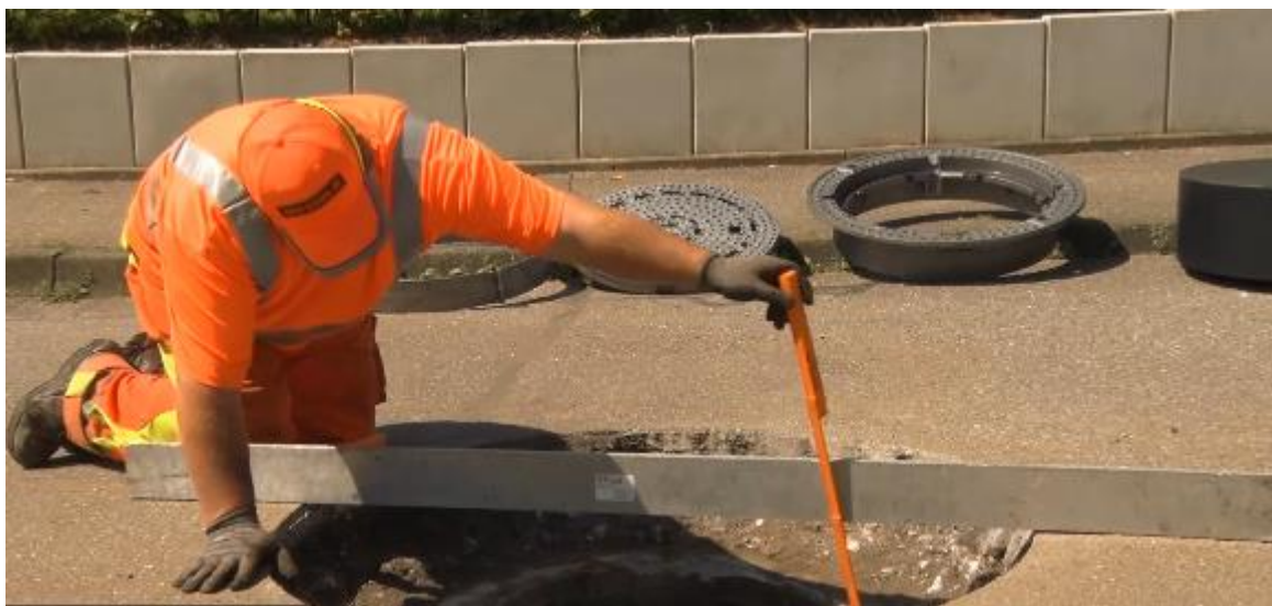
6. Установка регулируемой вставки
