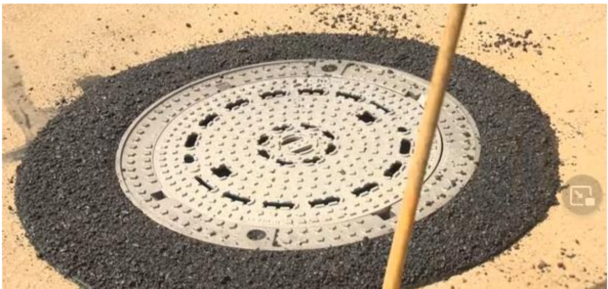
11. Производится установка люка и зачистка области люка
