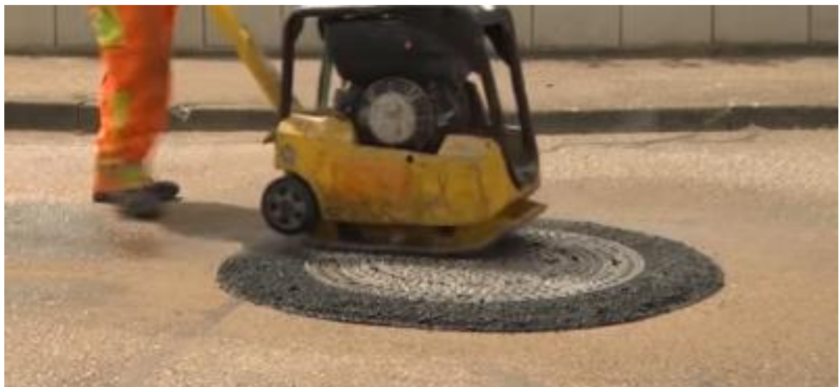
13. Финальный вид отремонтированного и отрегулированного колодца
